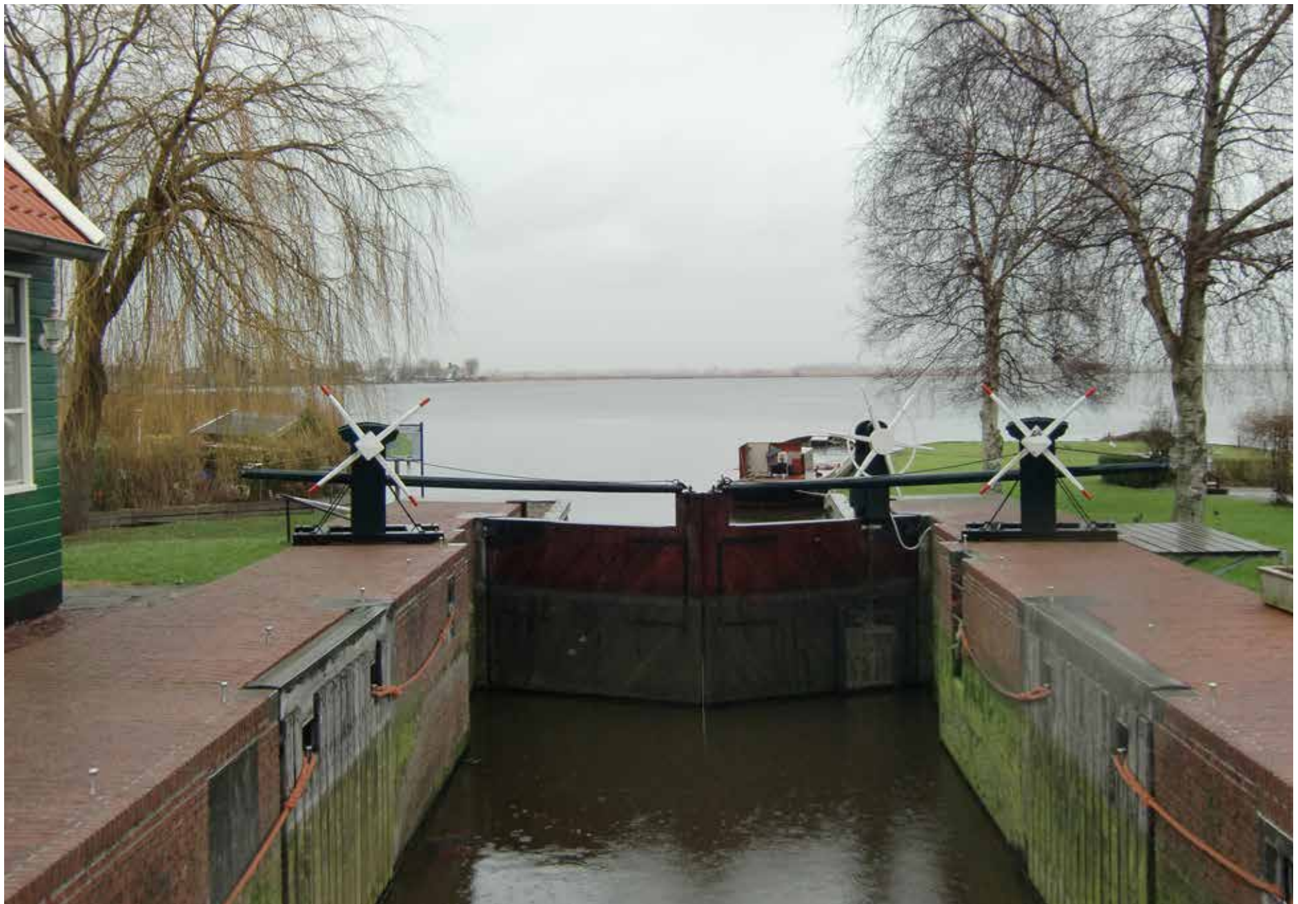
zicht over de Poelsluis en de waterplas De Poel
