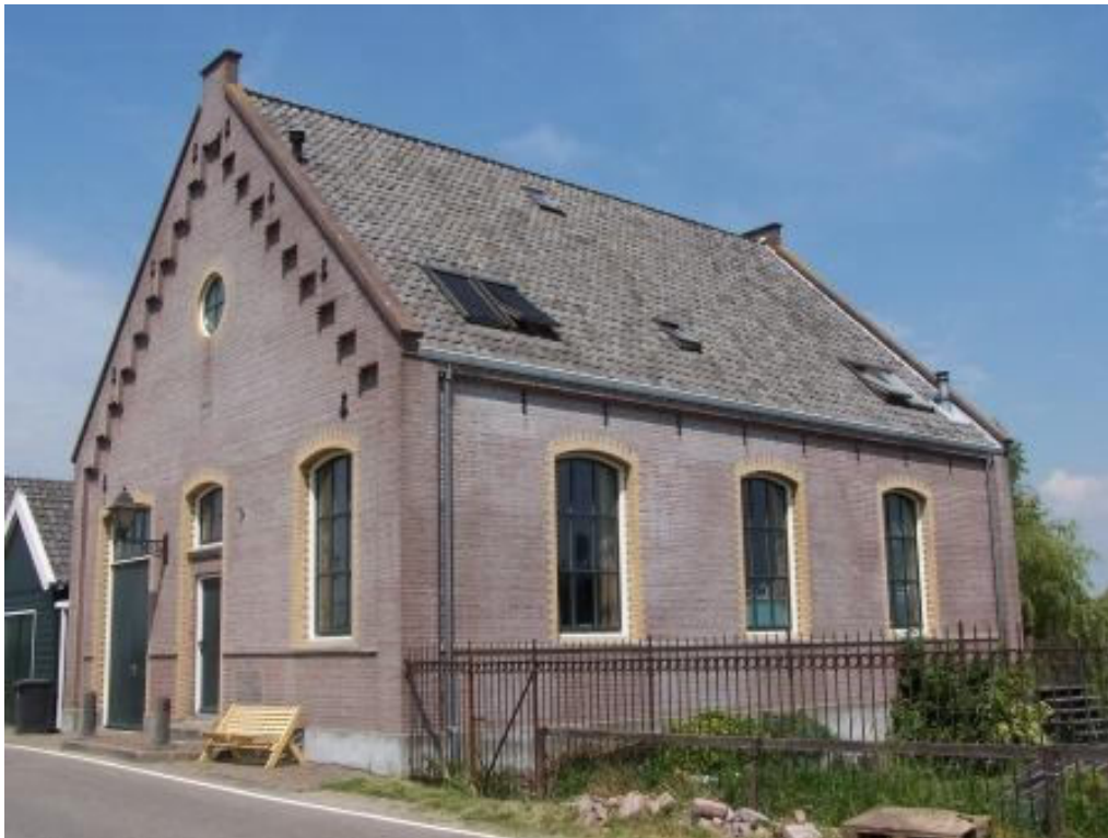
Afbeelding 2.14 Gemaal Ceres in Wormer. Bron: provincie Noord-Holland
